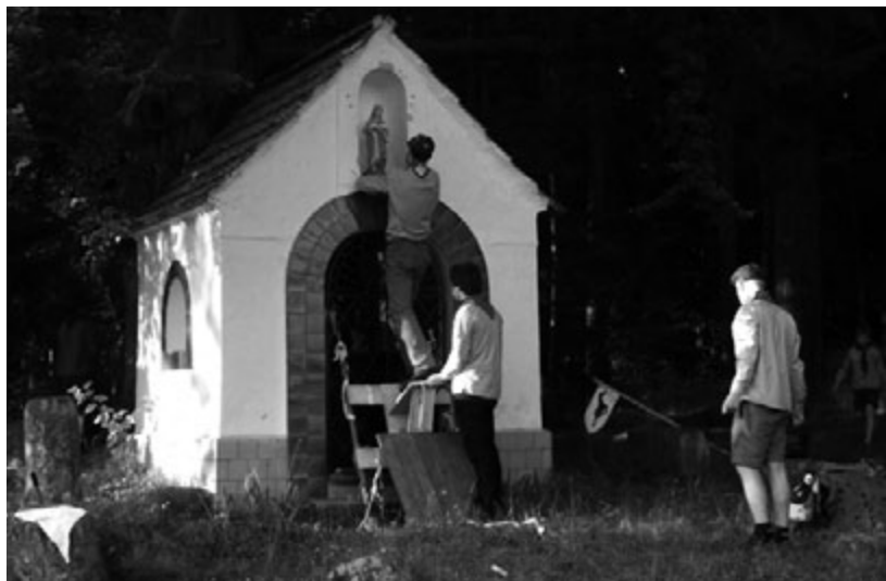
Instalace sochy do rošické kapličky.
