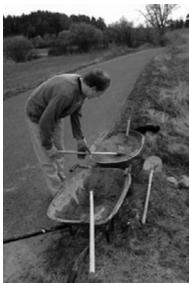
Betonování základu pro křížek.
