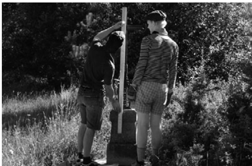
Usazování křížku s podstavcem do balvanu.
