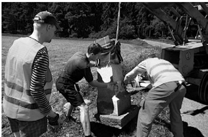
Usazování kamene za použití stavební techniky.
