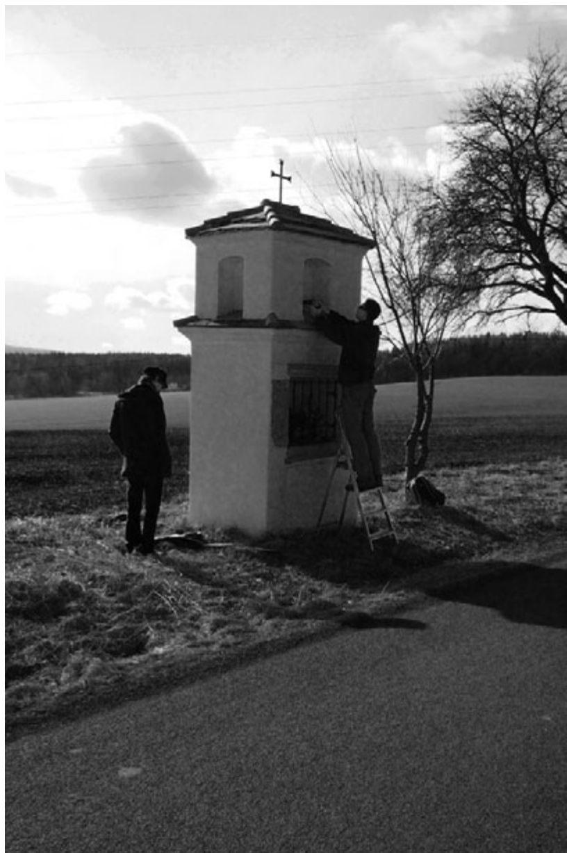
Z instalace plechových plastika (Hořovice).
