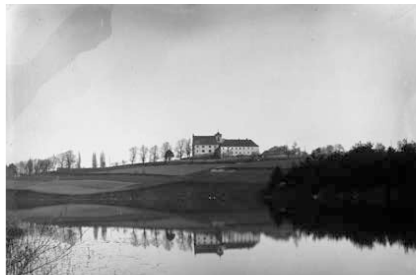
J. P. Hille: Lnáře. Klášter - celkový pohled, r. 1895
